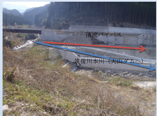
写真10 ダム上流の清流バイパス取水口
