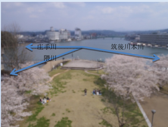
写真8 筑後川分派地点
