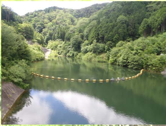
写真 11 湛水面積の小さな岩村ダム
