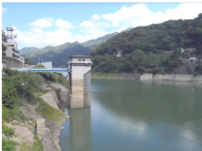
写真5 露出した選択取水設備（藤原ダム）
