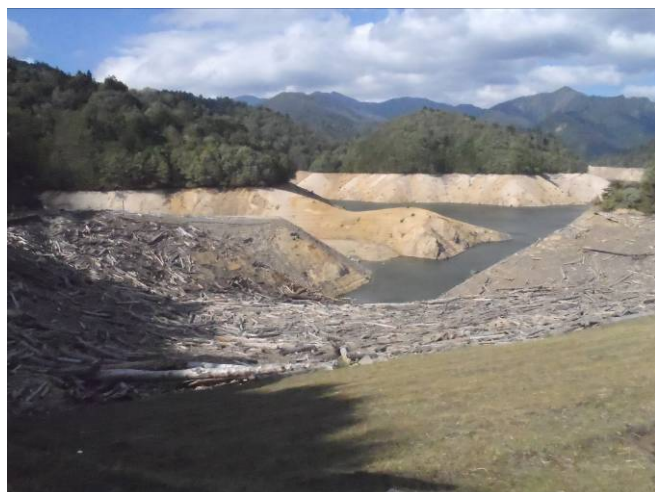
写真7 7%の貯水率の矢木沢ダム
