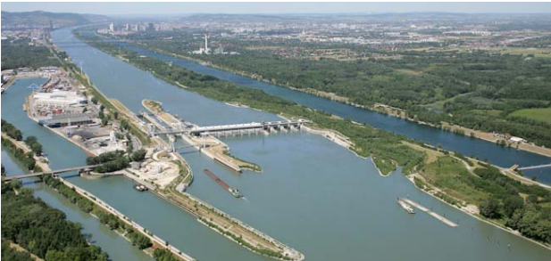
フロイデナウ発電所全景（VERBUND 公式 HP より）奥の運河と本流との間にある中州がそのまま魚道となっている。
