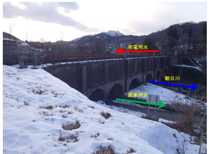
図6 駒橋発電所水路橋(国指定重要文化財)
