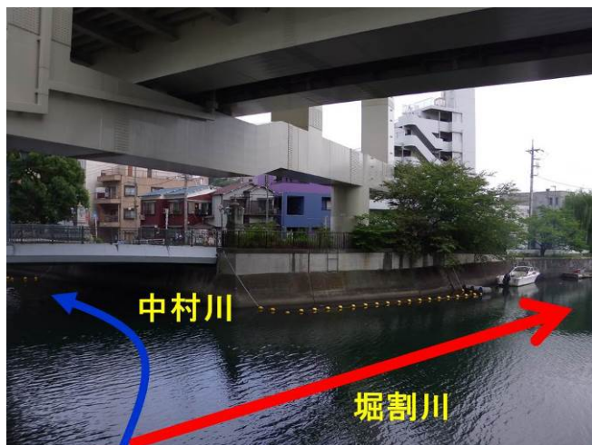
図8 中村川と堀割川分派点
