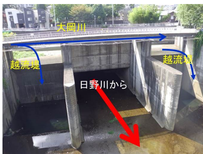
図3 大岡川分水路（中間地点）
