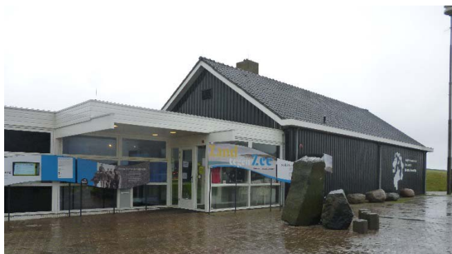
写真 4 Information Centre 外観
