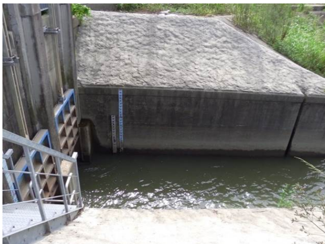
写真 3 遠賀堀川取水口
