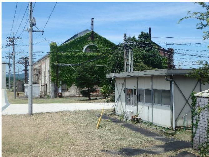
写真6 遠賀川水源地ポンプ室
