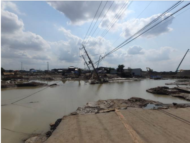
図-3 破堤点付近の道路の様子（9月16日撮影）
