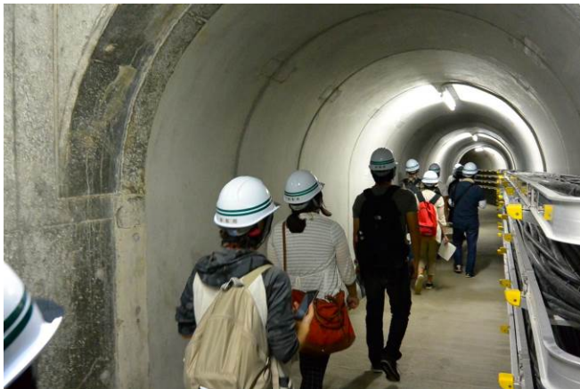
写真 2. 普段は入ることのできない監査廊へ
