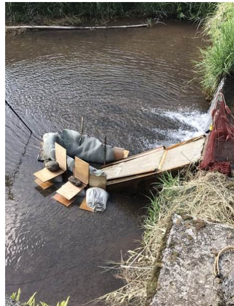
図6 網設置後の傾斜板の様子
