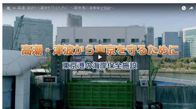
高潮・津波から東京を守るために ～東京港の海岸保全施設～
