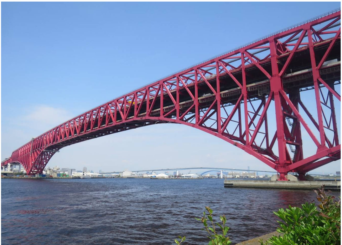
撮影：2019年7月（大阪府大阪市港区・港大橋）
