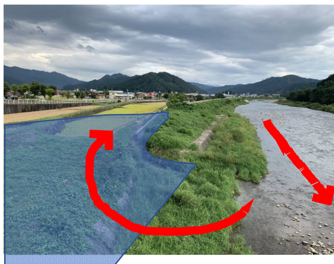
図6 岐阜県古川町大野町の霞堤
