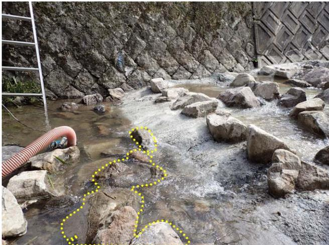
図3 魚道末端部と現河床との擦り付け部の落差
