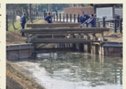
見沼通船堀 (東縁) 開門開閉実演状況
