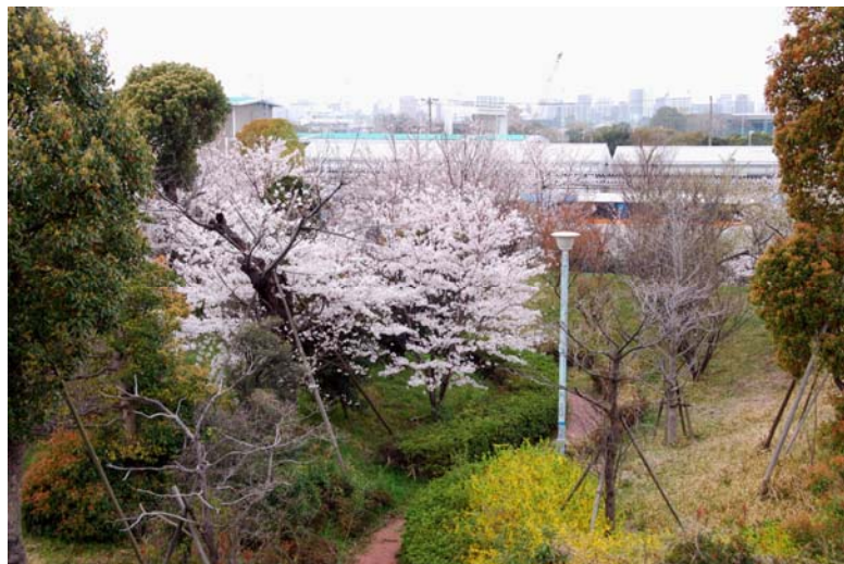
撮影◎上原励 2013年3月 東京都大田区・森ヶ崎水再生センター
