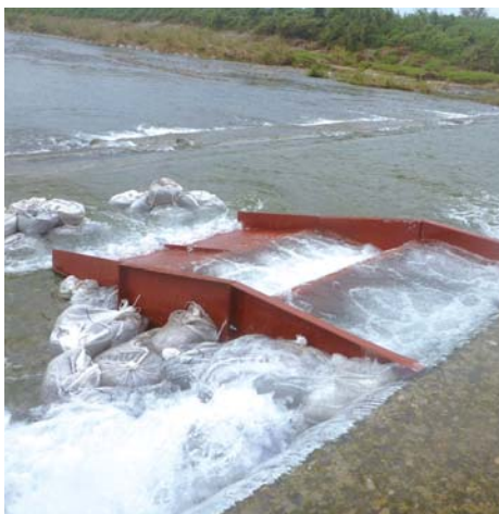
【市民らが設置した鋼製の仮設魚道】
