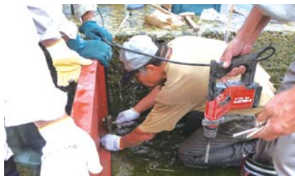
工事前のコンクリート面への魚道の固定
