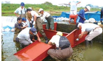
位置を決めて魚道の組み立て作業
