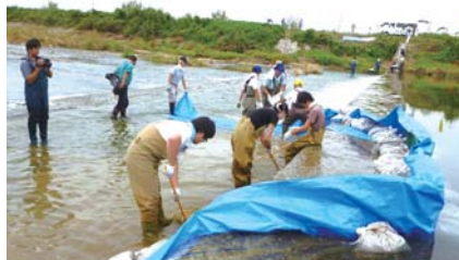
工事前の水止めと接地面の掃除
