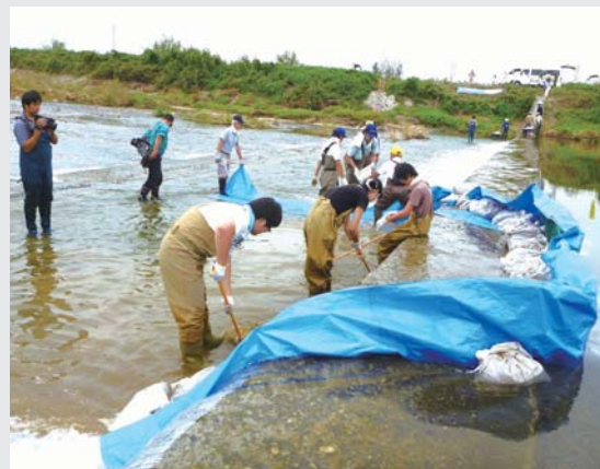
【材料】 組み立て式鋼製魚道 (米原市オリジナル品)、ハンマードリル、土のう、ブルーシート (水止め)
