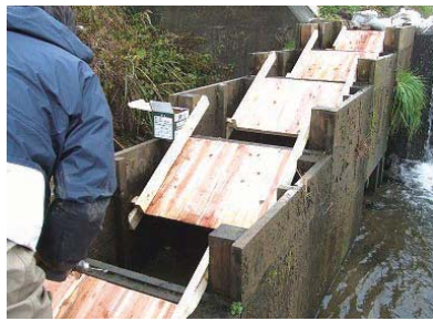
[箱と箱の間に「滑り台」を設置]
