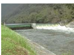
【農業用井堰の連続転倒。上流部より5基をタイミングよく連続転倒して少洪水を発生】
