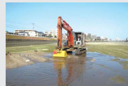
■ スケルトンバケット付パワーショベル パワーショベルの先をスケルトンタイプにすることで効率的に砂に埋まっている礫を掘り出します！パワーショベルはシロウオ組合が築かけに使うものを利用して、経費を抑えています。
