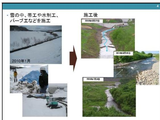
そして、2010年1月に、雪の中で帯工や水制などを設置し、雪の中のため石だか雪だかわかりづらいですが、こういうものを設置していきました。施工後、春になって通水した写真が右側です。ここにバープ工がありますが、帯工も設置しました。夏になり流量を少し増やしてみると、植生も回復し、流れも自然に近づき、削られるところは削られたりして、だんだんと自然が蘇ってきている状況が見られています。
