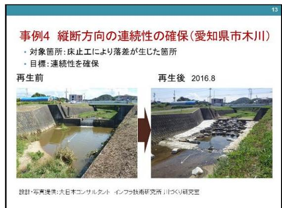
事例の四つ目です。こちらは、縦断方向の連続性を確保しようということで、再生前はこのような落差があったのですが、その落差を解消するために石組みなどを使って段を小分けにして、魚道を設置しているというところです。
