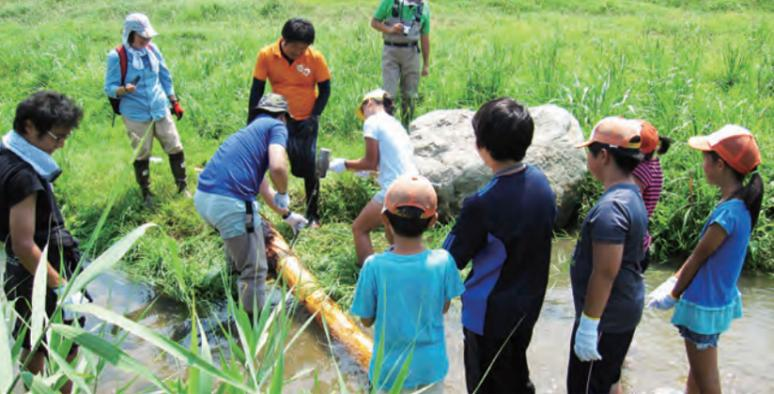
福岡県・上西郷川での間伐材水制による多様な流れの創出
