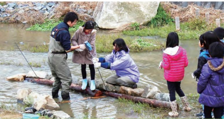
福岡県・上西郷川での間伐材水制による多様な流れの創出
