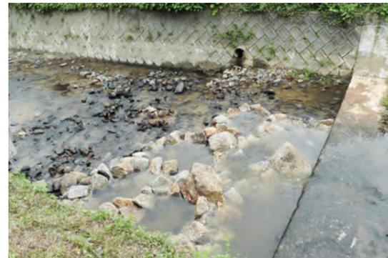
大人の力作（分散型落差工の魚道）
