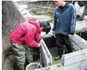
手作り魚道の設置作業
