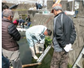
ワンコイン・バープ工法の設置
