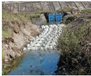
簡易魚道（左）施工直後（右）施工後半年
