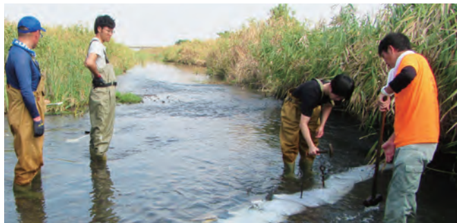
バープ工の設置
