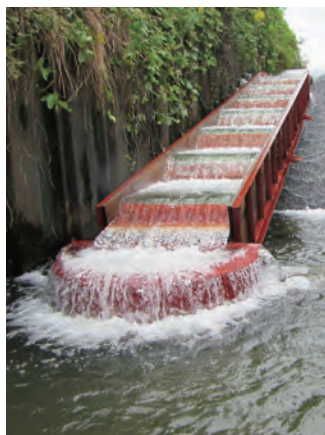
落差工への魚道設置
