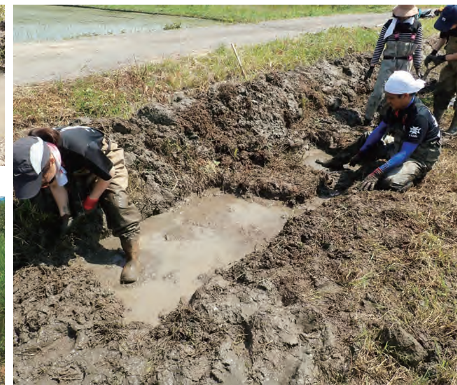
土を切り取り、水溜まりをつくる
