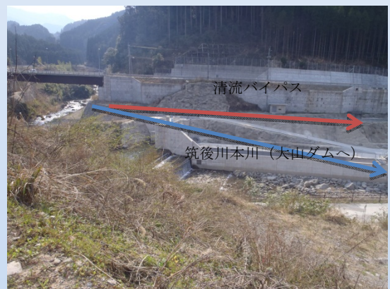
写真10 ダム上流の清流バイパス取水口
