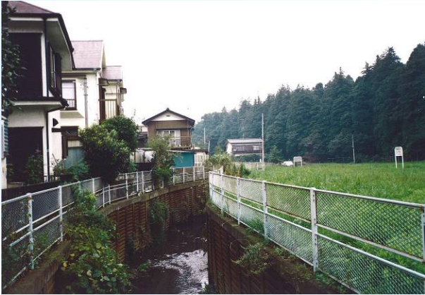
写真4 施工前の東山の水辺（当日配布資料より）
