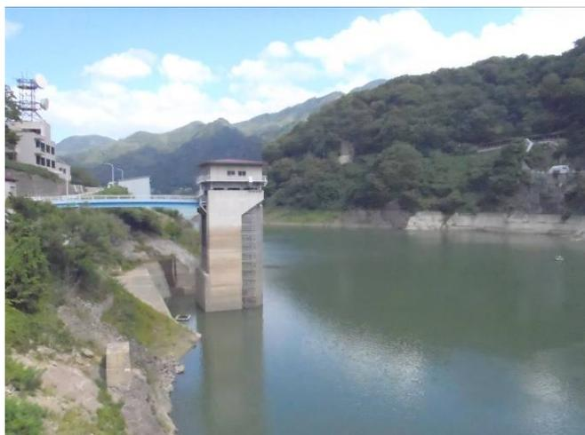
写真5 露出した選択取水設備（藤原ダム）
