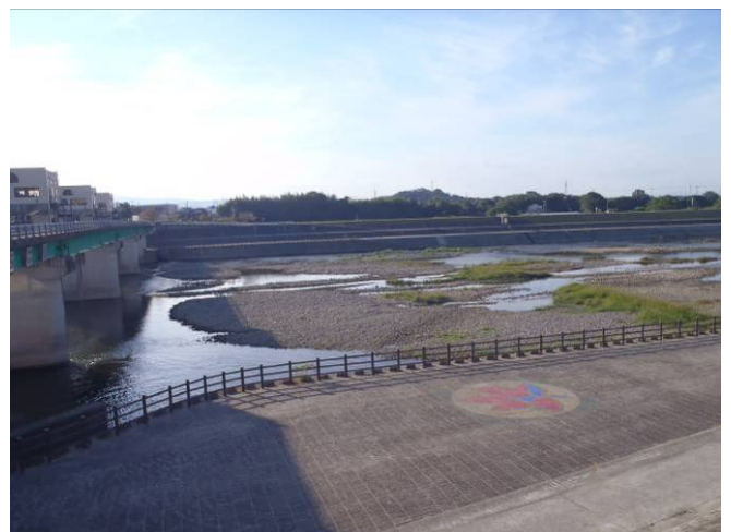
写真17：水害後土砂のたまった山国川(平成大堰)
