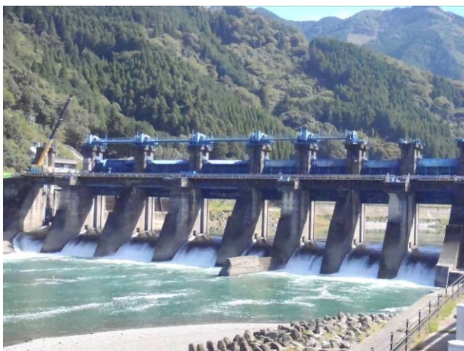
写真 10：荒瀬ダム撤去の現場
