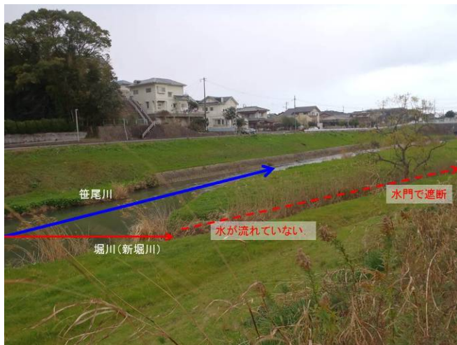
写真6 笹尾川と堀川(新堀川)の分派点
