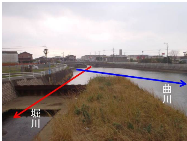
写真5 交差する堀川と曲川（堀川は鉄板で遮断）
