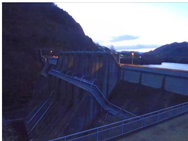
図9 城山ダム（堤体は県道）
