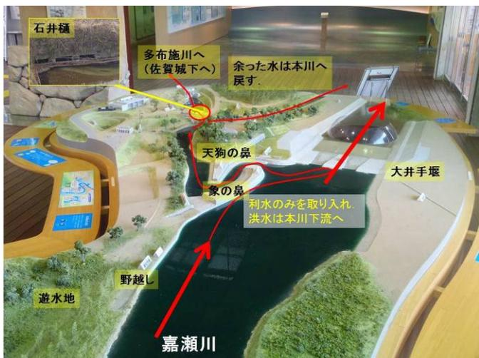
図3 成富兵庫が築いた石井樋の水利システム
