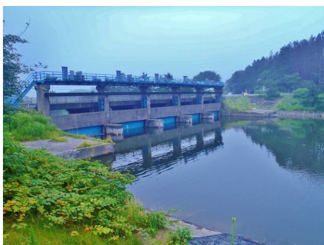
図9 高瀬川放水路
