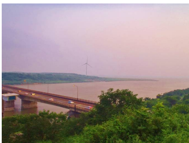
図 19 雄物川放水路（河口）
