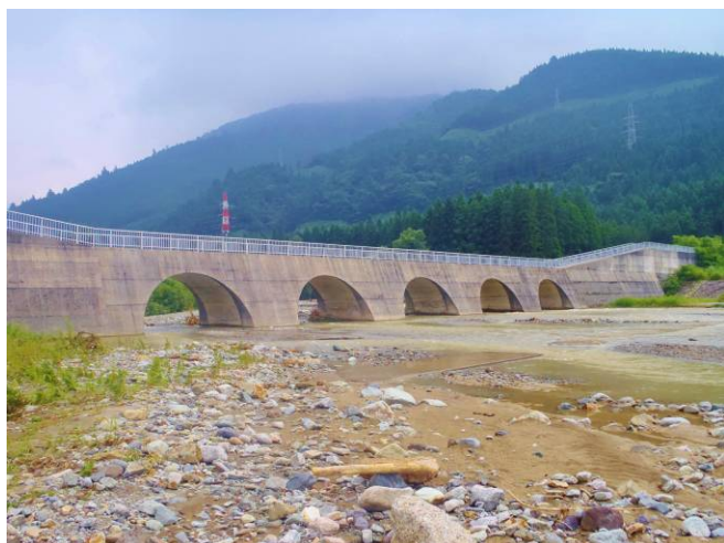
図 18 生内川大暗渠砂防堰堤
