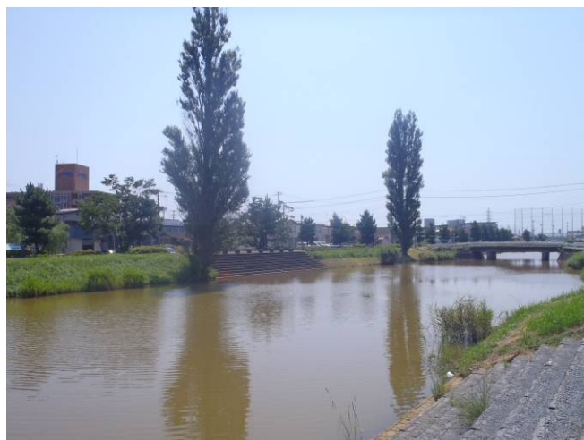
図 2 7 津波が遡上した北上運河
