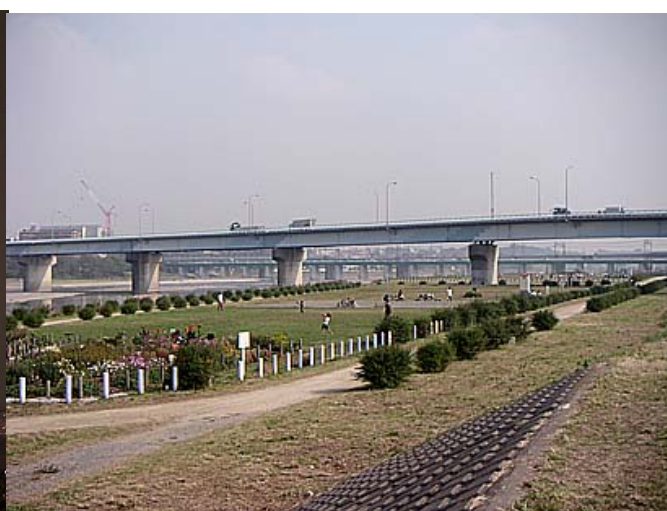
河原から見た新二子橋
